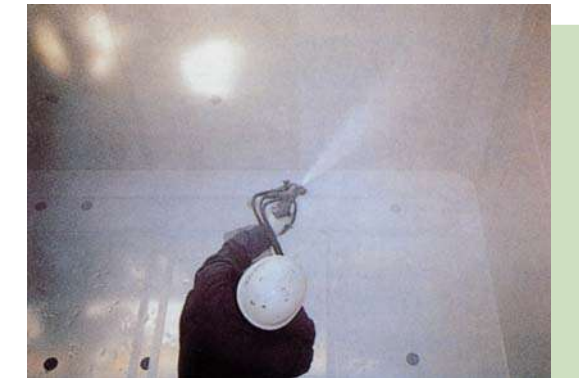
防水材 レジマックス1000 吹付け
