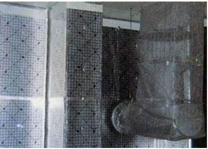
断熱材施工
