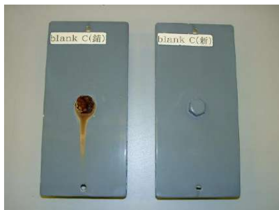
写真 4：従来工法(錆面シーラー+重防食塗料)
